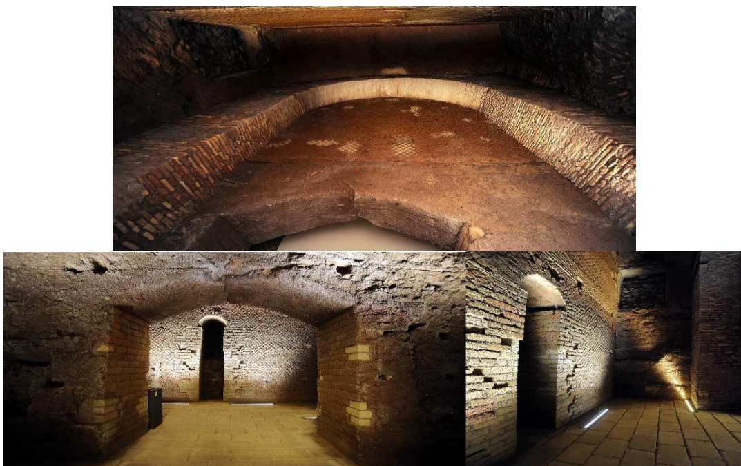
I locali romani prima e dopo gli interventi di pulitura e restauro conservativo
